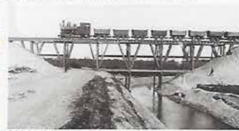
Schmalspurbahn beim Kanalbau.
