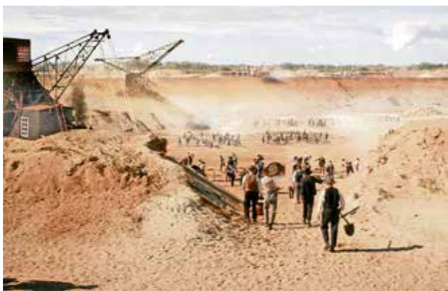
Mit Schaufeln eine Wasserstraße bauen: Diese Spielfilmszene zeigt die Bauarbeiten am Nord-Ostsee-Kanal. FOTO: NDR
